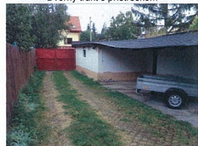
Garáž s prístreškom a vstupnou bránou
