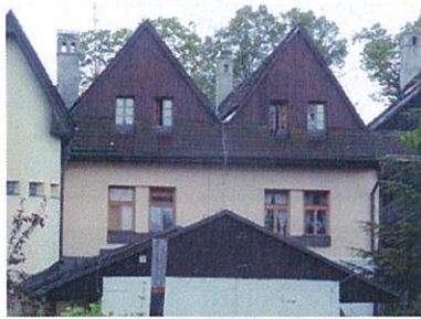
Pohľad zo dvora (uličný trakt)
