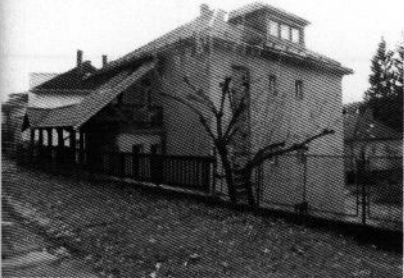
Administratívna budova s prístreškom – pohľad severozápadný
