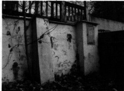
Oporný múr na hranici parc.č. 2209 a 5409/16
