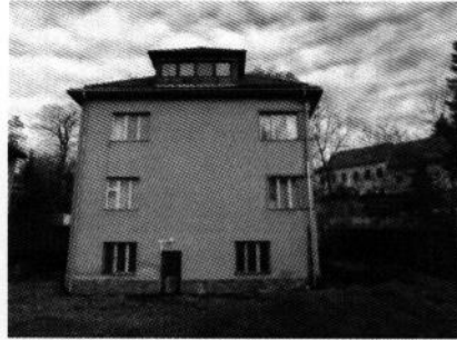
Administratívna budova s prístreškom – pohľad juhozápadný
