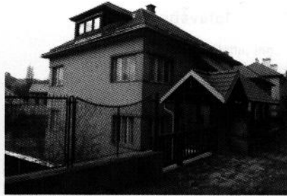
Administratívna budova s prístreškom – pohľad juhovýchodný
