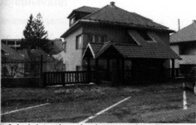
Administratívna budova s prístreškom – pohľad severovýchodný
