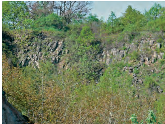
Foto 2. V zadnej strane lomovej steny je pozorované postupné vztyčovanie stĺpcovej odlučnosti do subvertikálneho smeru (© P. Pachinger).
