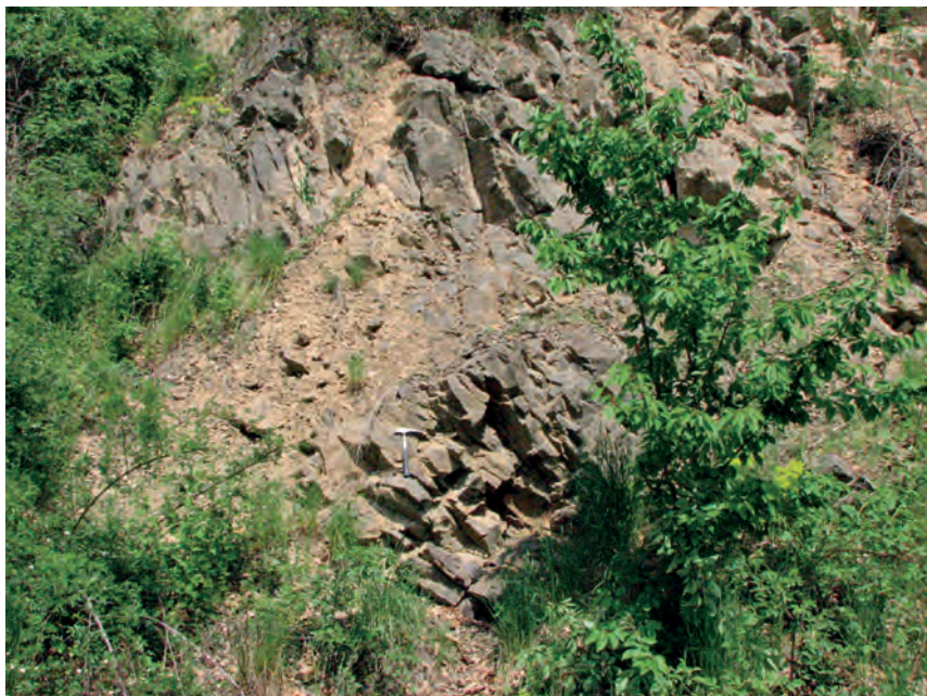
Foto 2. V ľavej časti steny opusteného lomu je pozorované postupné vztyčovanie doskovitej odlučnosti do subvertikálneho úklonu (© P. Pachinger).
