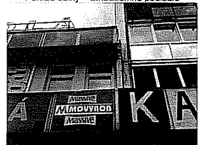
Pohľad na styk oboch objektov
