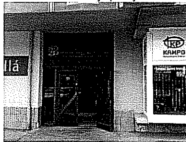
Detail vstupu do objektu
