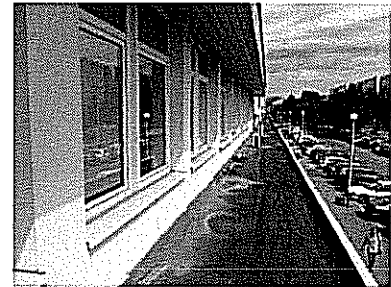
Pohľad čelný - 2.nadzemné podlažie
