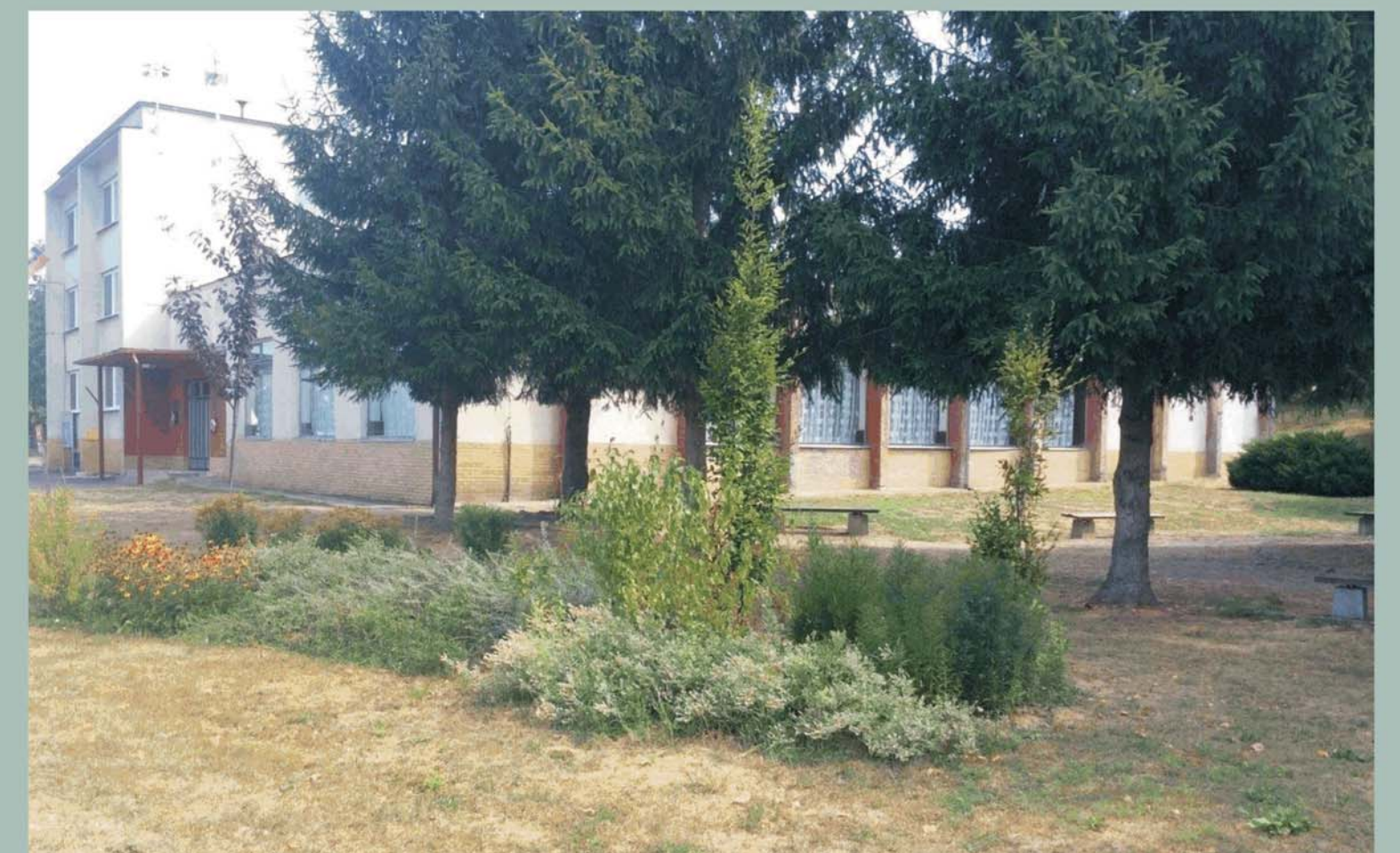
Dažďová záhrada využíva zachytenú dažďovú vodu zo striech alebo zo spevnených povrchov a umožňuje jej vsak do pôdy, ako aj výpar do ovzdušia, čím ochladzuje okolité prostredie.
