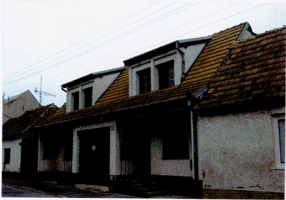
Administratívna budova č.súp. 1047, k.ú. Trnava - pohľady
